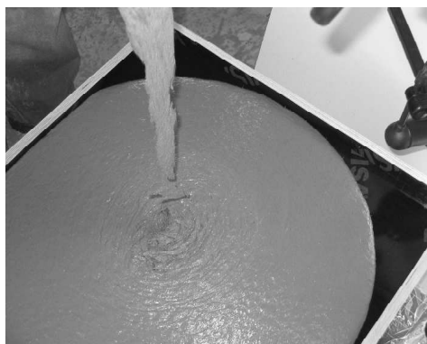
Figure 2. Coulage d'une dalle - Coulage au centre de la dalle.
