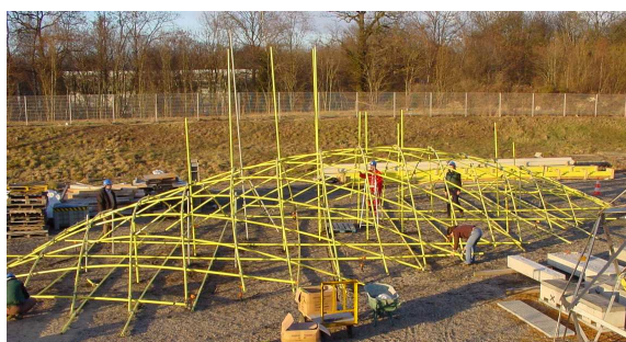
Fig. 3 : Phase de montage avec des étais
