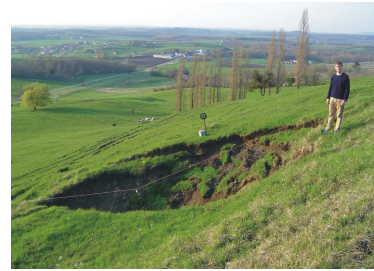
Figures 2.a. Montée de voûte, 2.b. Soufflage du mur, 3.c. Cuvette de fontis en surface.
